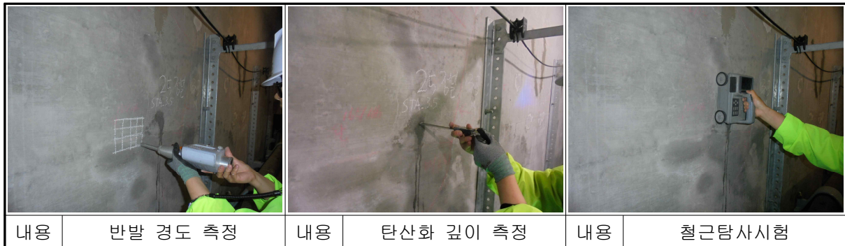
【사진 3.4】 문발SS인출 전력구 재료시험 전경
